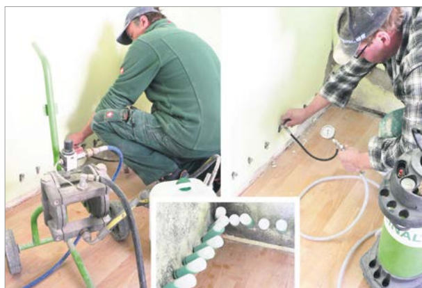
Nachträgliches Anbringen einer Horizontalsperre. Je nach Beschaffenheit des Mauerwerks wird die Veinal Silikonharz-Lösung mit Druck oder drucklos injiziert.
