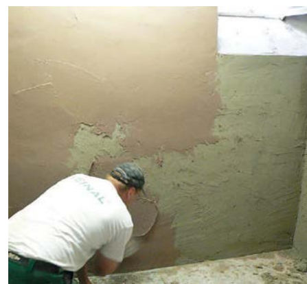
Nach der Salzbehandlung wird die polymere Harzabdichtung auf den Sperrputz aufgebracht.
